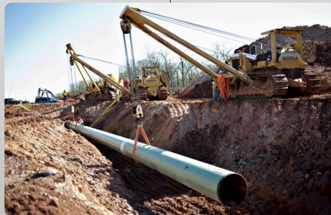
Прокладка и монтаж инженерных сетей
