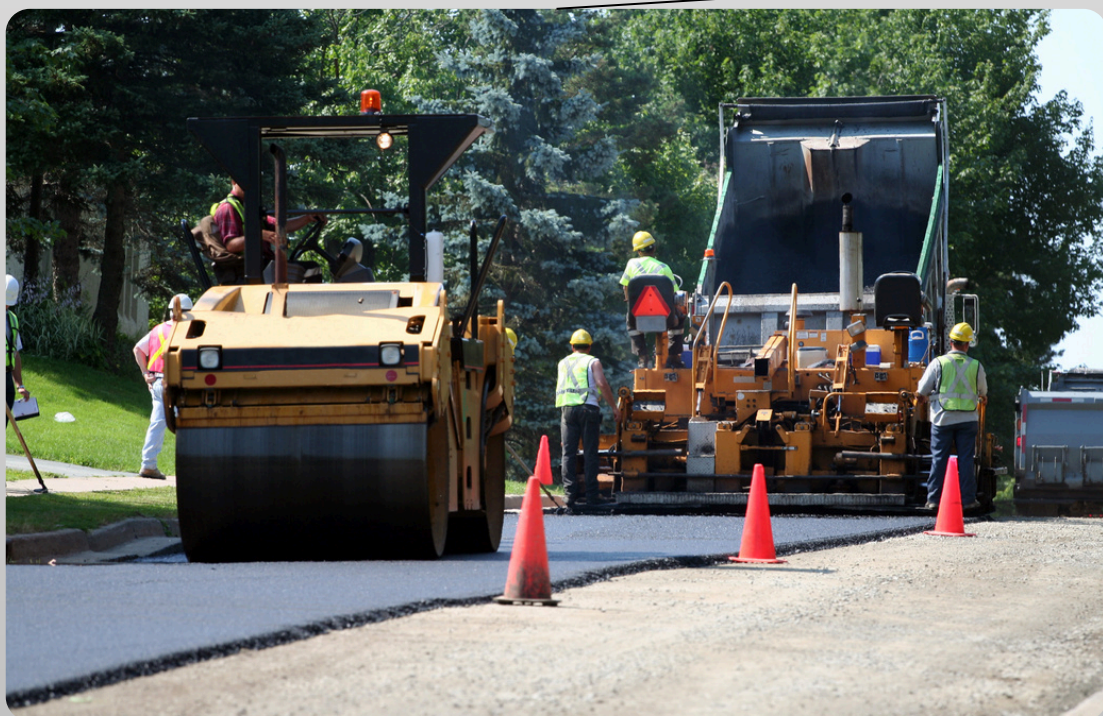
Строительство и реконструкция автомобильных дорог
